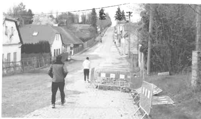
Rekonstrukce ulice Na Celné – foto: L. Jenček ml.
